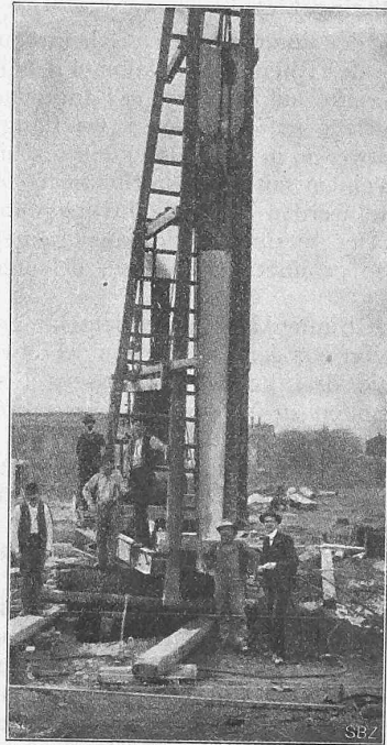
Abb. 37. Rammkern in die Stahlhülse eingeführt.
