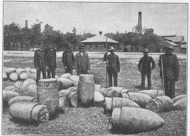
Abb. 42 Pfahlspitzen aus mit Streckmetall armiertem Beton.
