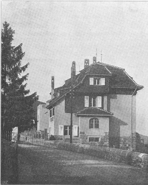
Abb. 12. Ansicht der Seitenfassade der Häusergruppe von Südwesten.
