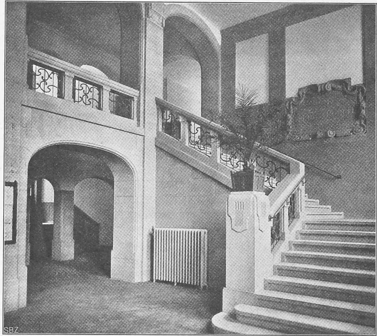
Abb. 12. Blick aus der Erdgeschosshalle nach dem Treppenhaus.
