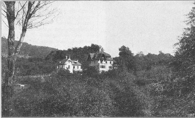
Abb. 11. Ansicht der Villa «Im Oberland» an der Hofstrasse in Zürich V von Süden. Erbaut von Architekt Th. Oberländer-Rittershaus in Zürich V.
