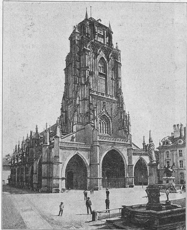
Abb. 5. Der Turm des Münsters zu Bern vor dem Ausbau.
