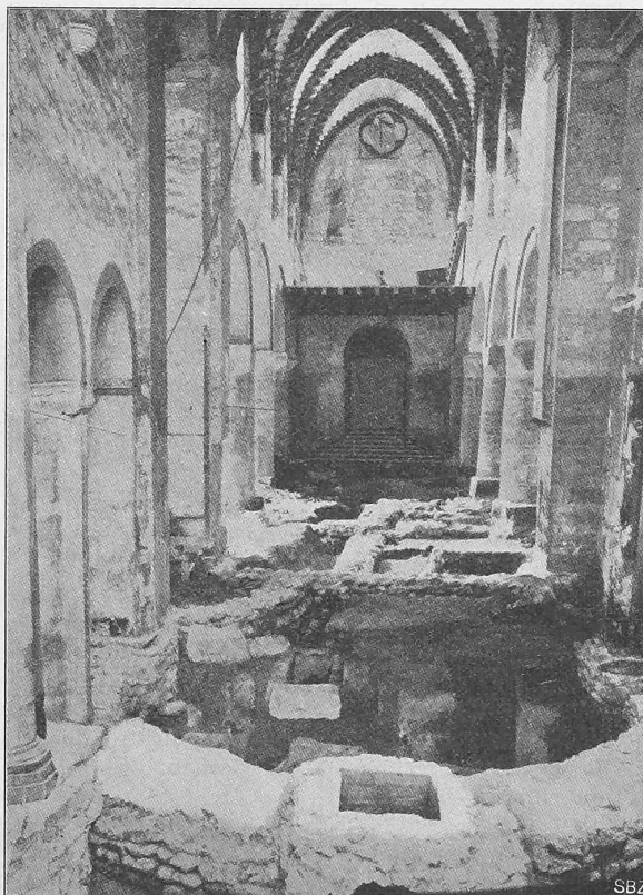
Abb. 9. Blick in das Schiff der Kirche zu Romainmôtier nach der Blosslegung der ältern Mauerzüge.
