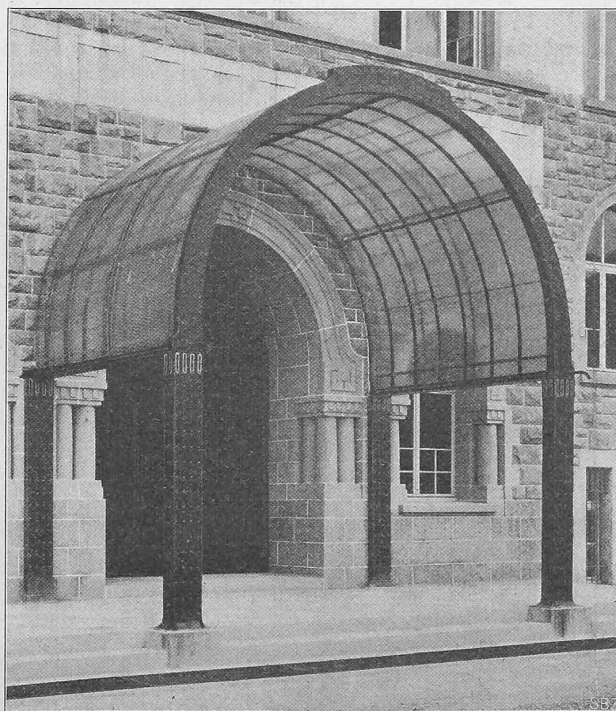
Abb. 9. Vordach des Hauptportals des Hadwigschulhauses.
