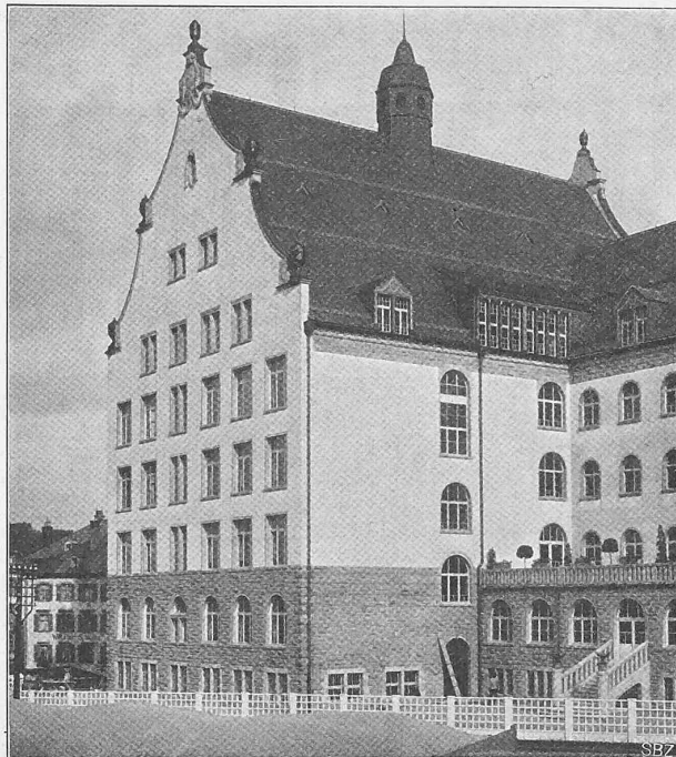
Abb. 8. Flügelbau der Rückfassade.
