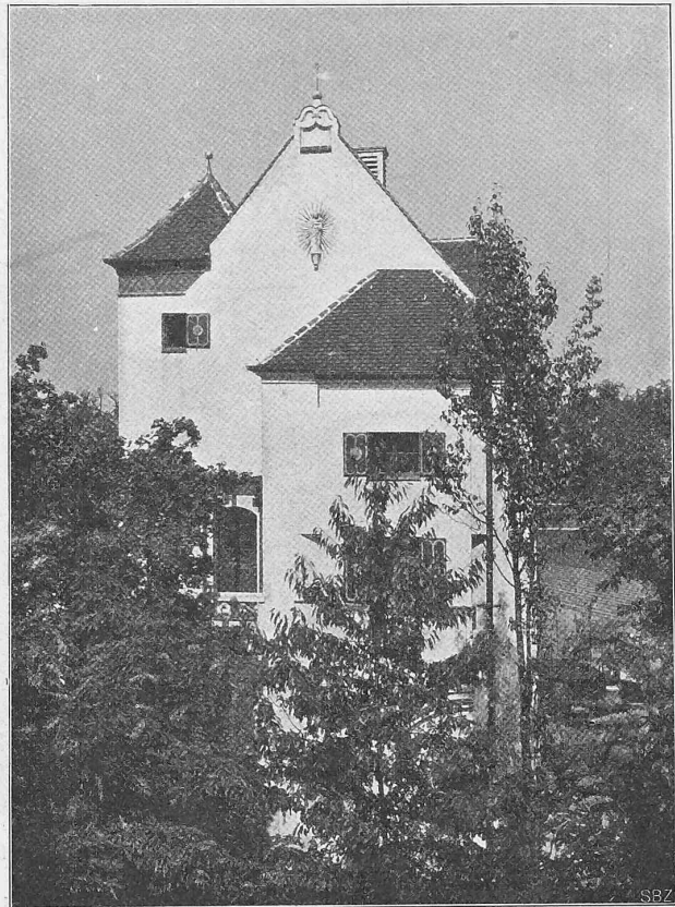
Abb. 7. Ansicht des Giebels nach der Gartenseite.
