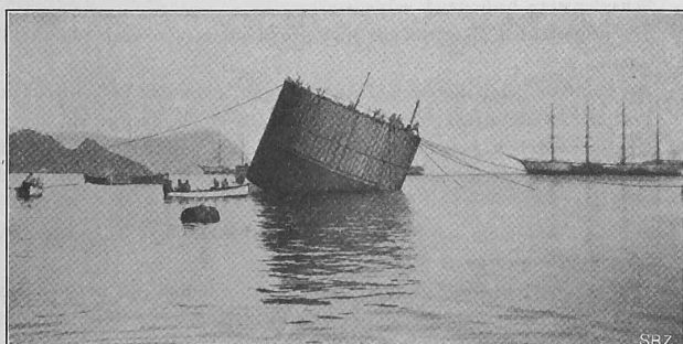
Abb. 15. Senkkasten an der Brückenbaustelle vor der Versenkung.
