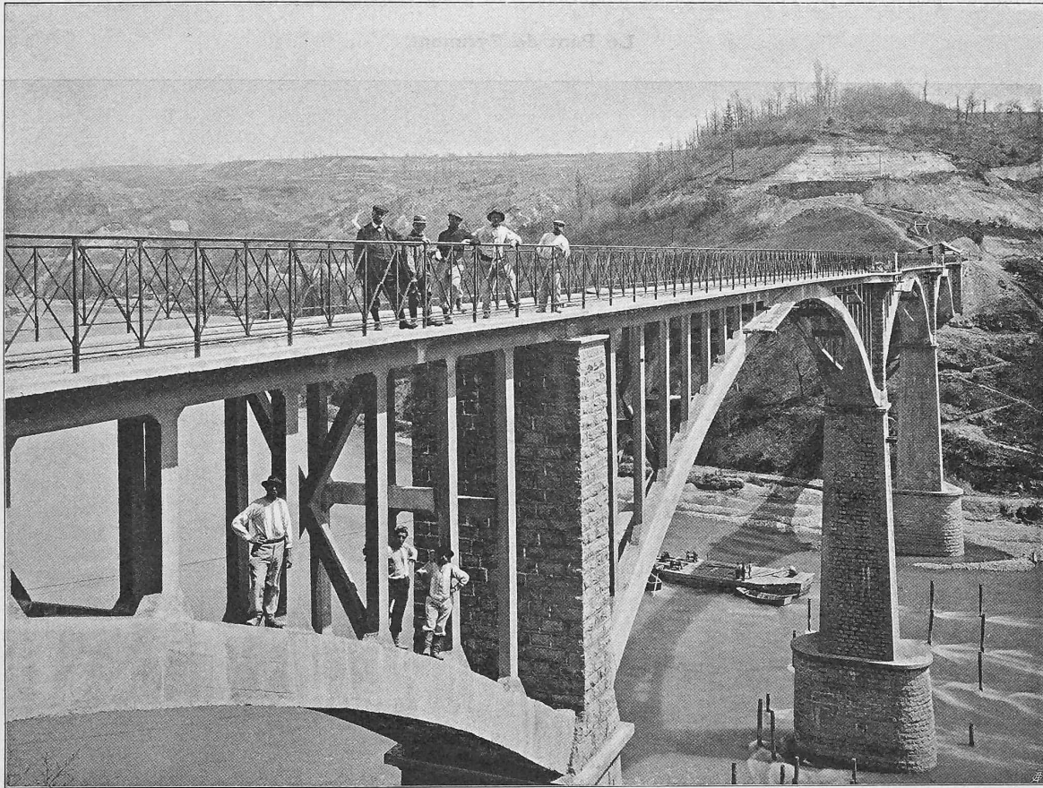
Fig. 6. Vue des colonnettes portant le tablier supérieur.
