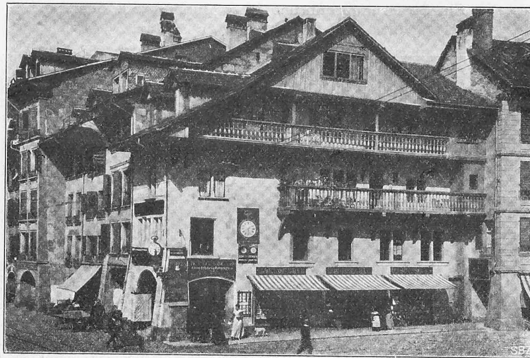
Abb. 1. Ansicht der Häuser 2, 4 und 4a an der Ecke Waisenhausplatz-Spitalgasse. Haus Nr. 2 stammt aus dem Anfang des XVI. Jahrhunderts. (Nach einer Photographie der Société Franco-Suisse [Freitag & Cie.] in Bern.)
