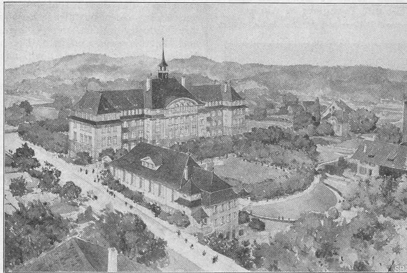
Ueberblick über Schulhaus, Turnhalle und Spielplätze von Norden.
