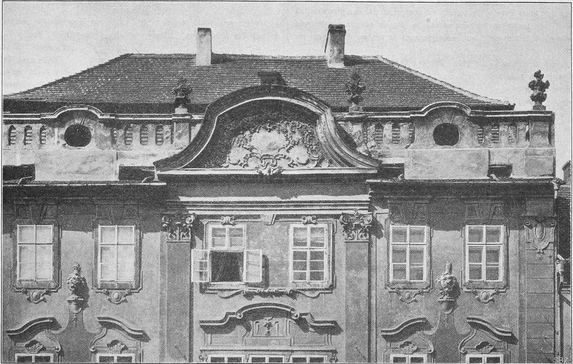
Abb. 2. Bekrönung der Mittelpartie und Fassadendetails eines Hauses am Pohorelec in Prag.
