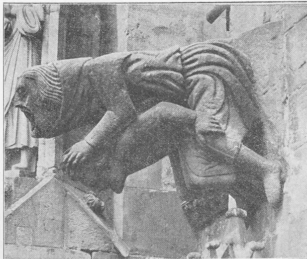
Abb. 3. Wasserspeier an der südlichen Langhausfassade.
