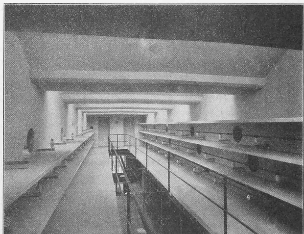
Abb. 82. Galerie im Mittelbau in Lomazzo.
