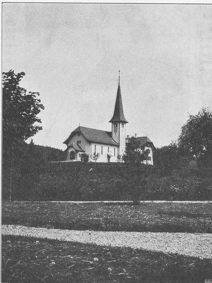
Abb. 1. Gesamtansicht von Kirche und Pfarrhaus.
