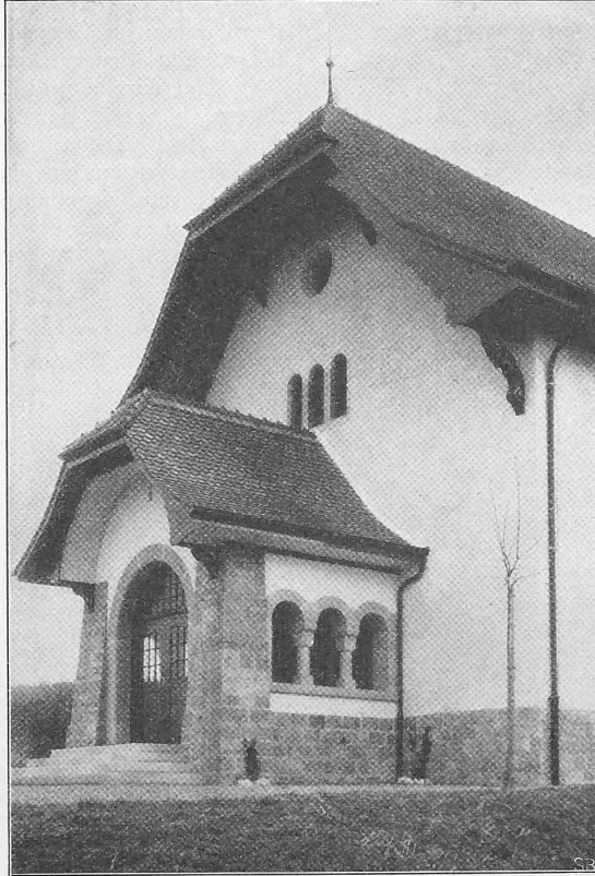
Abb. 3. Vorhalle und Giebel des Kirchenschiffs.
