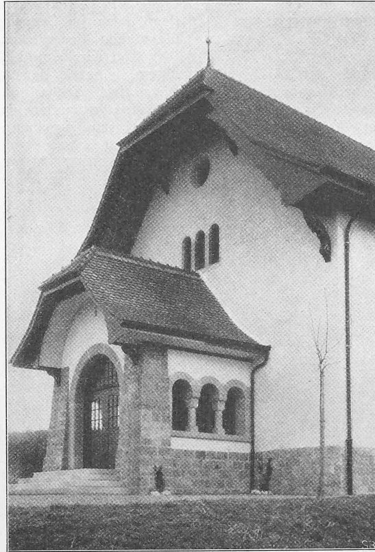
Abb. 3. Vorhalle und Giebel des Kirchenschiffs.
