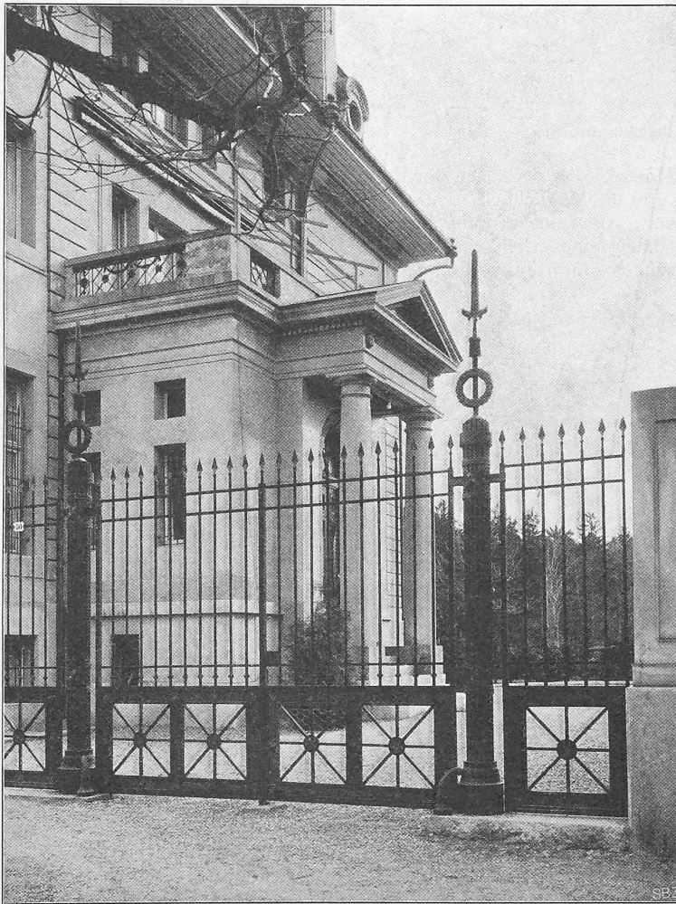
Abb. 19. Einfahrt zur bayrischen Gesandtschaftsvilla mit Haupteingang.
