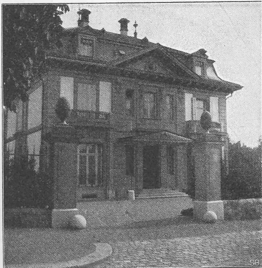
Abb. 16. Die englische Gesandtschaftsvilla. — Strassenfassade.
