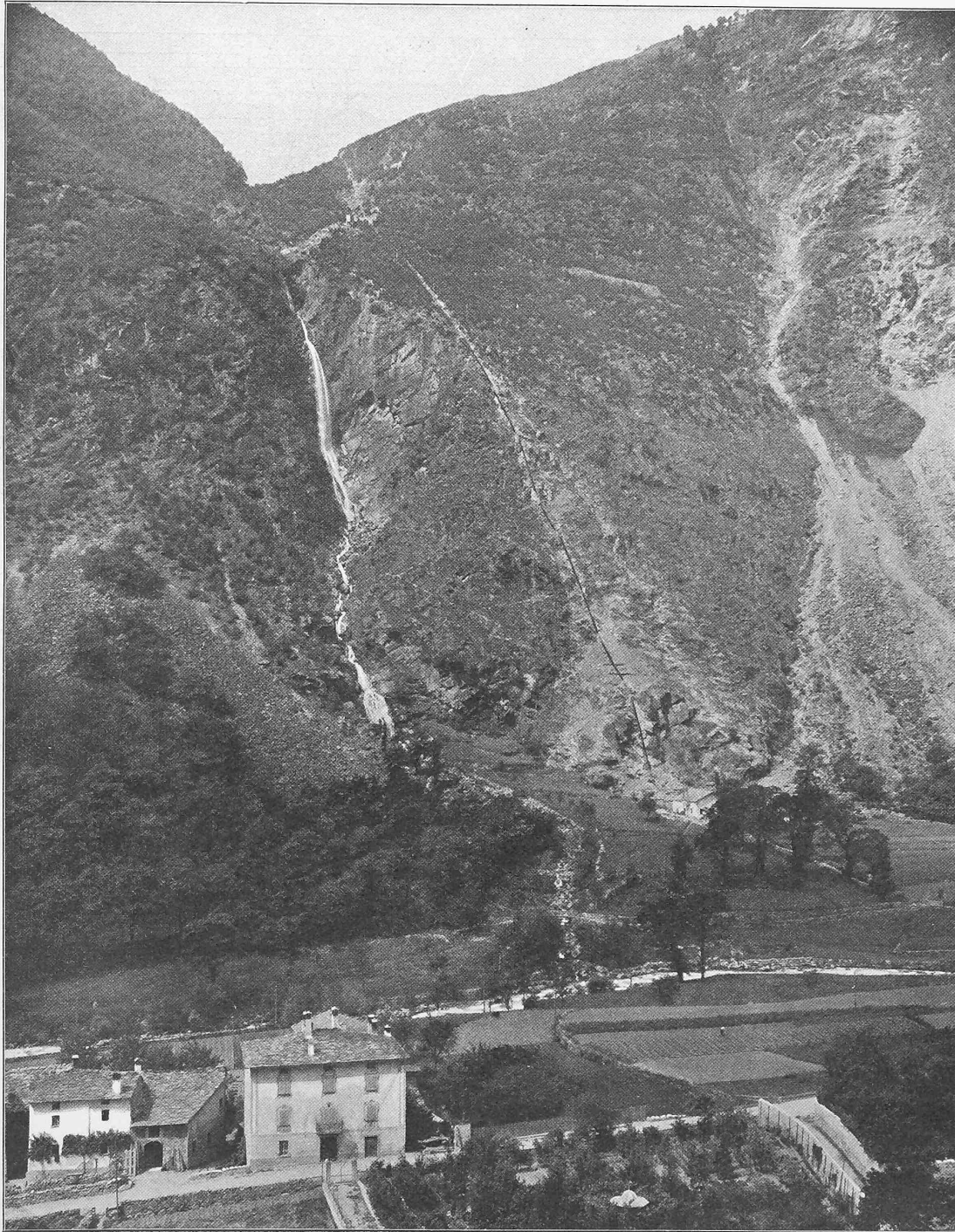
Abb. 13. Ansicht des Sajento-Kraftwerkes (Hilfszentrale).
