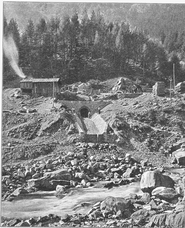
Abb. 17. Stollenfenster Nr. 2 mit Ueberlauf.
