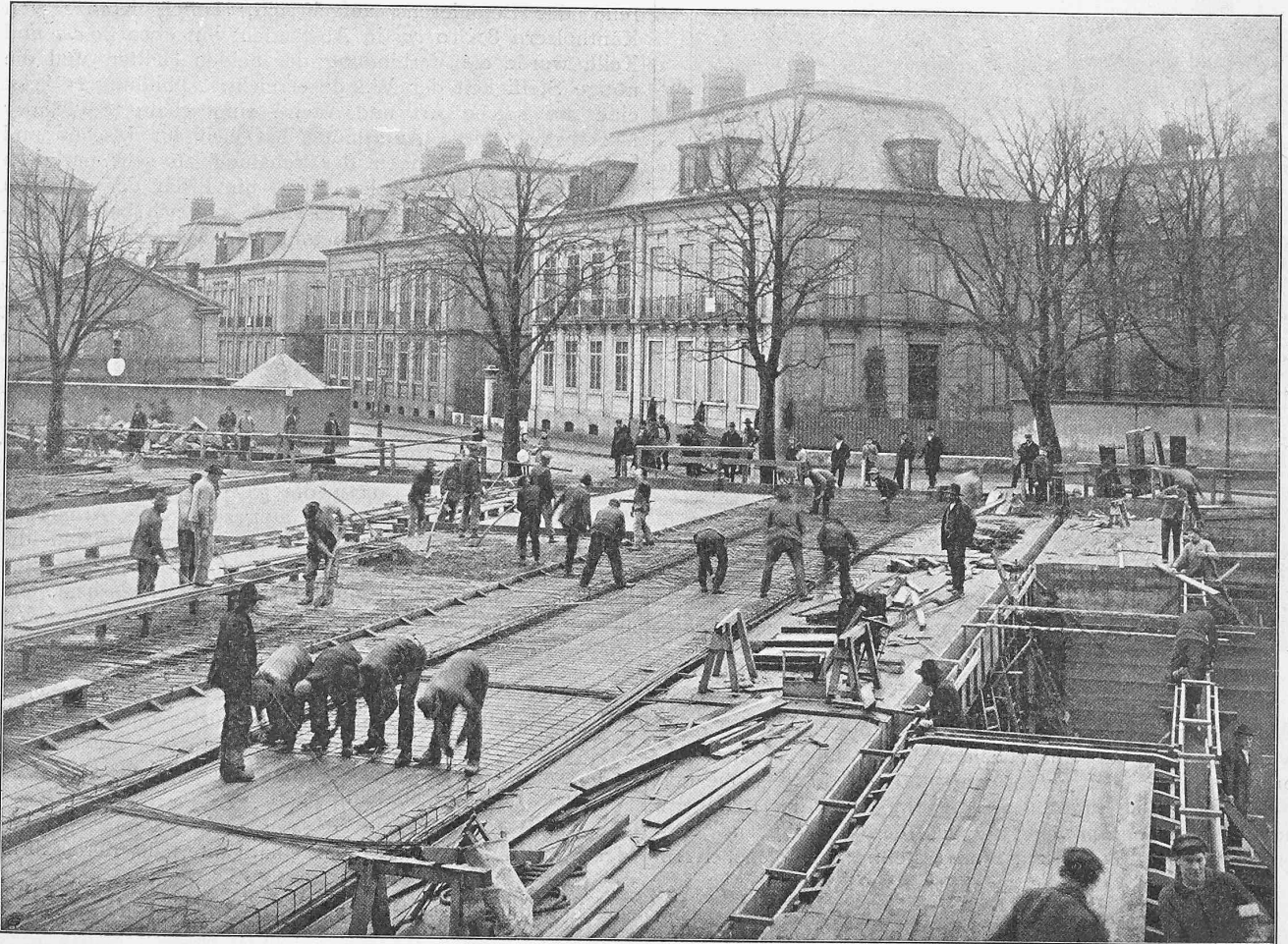
Abb. 17. Bauvorgang beim Eindecken. Von rechts nach links: Einschalen der Deckenträger und der Decke, Einlegen der Eisen, Betonieren der Decke längs einer Dilatationsfuge.
