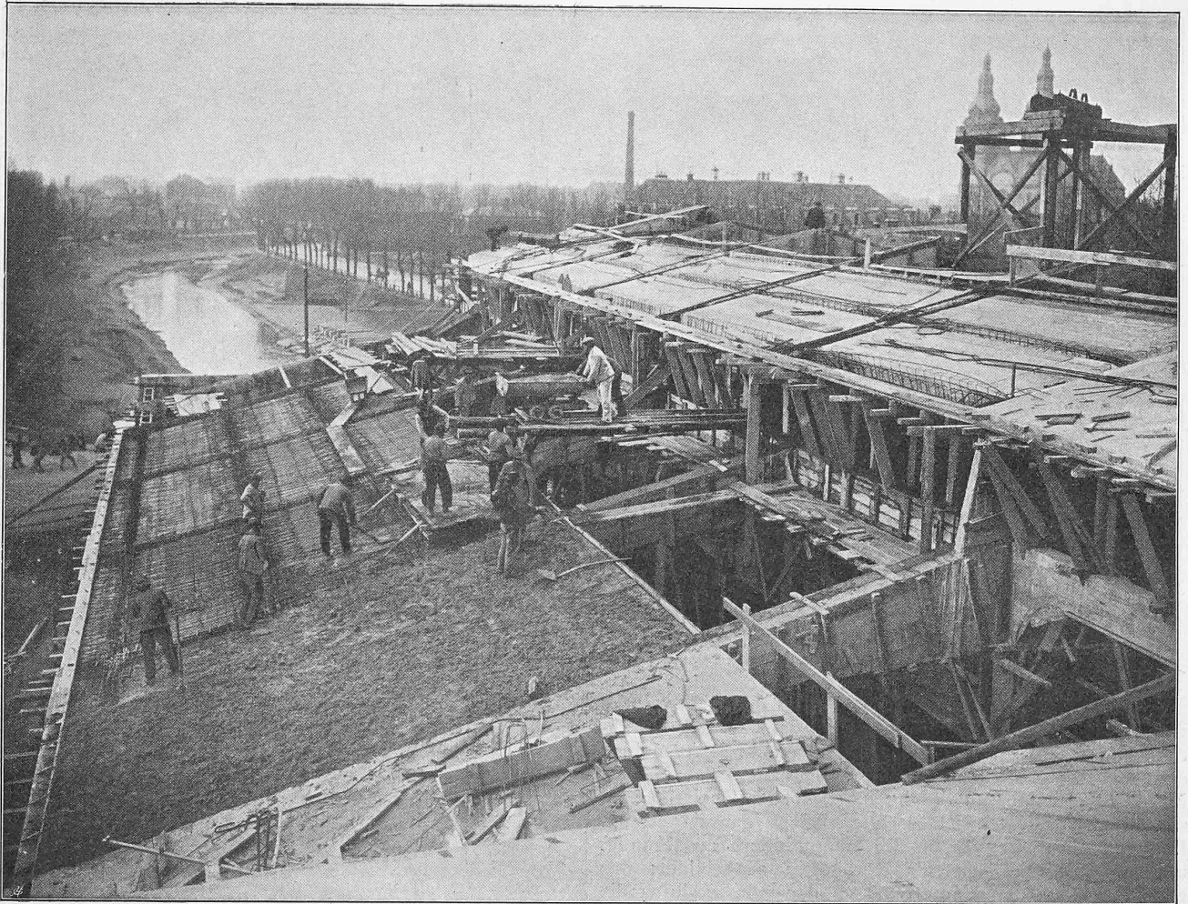
Abb. 23. Bauvorgang bei Erstellung des Daches der Markthalle; Zuführung des Betons.
