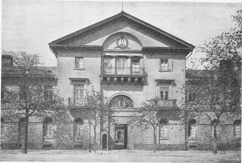
Abb. 1. Mittelbau der ehemaligen badischen Münzstätte zu Karlsruhe i. B.
