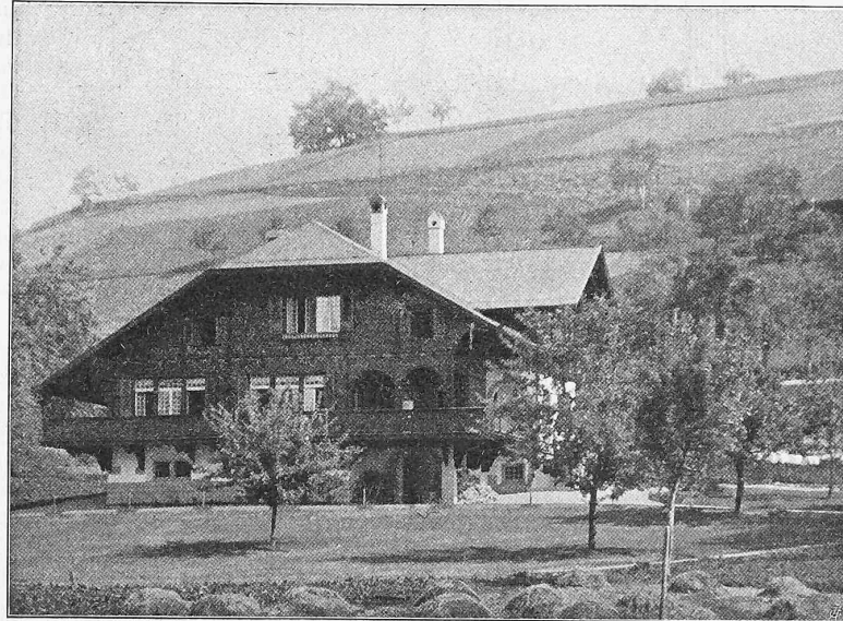
Abb. 1. Ansicht der Hauptfront des Hauses.
