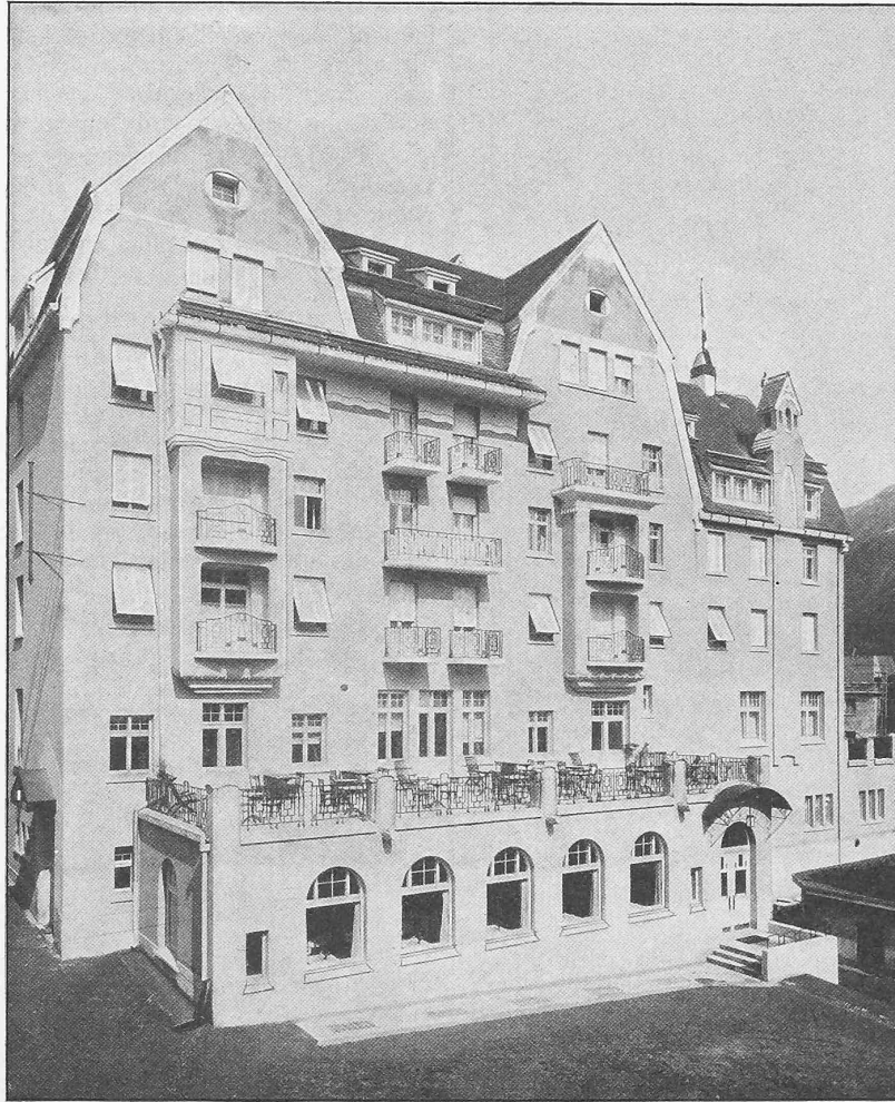
Abb. 3. Ansicht der Hauptfassade am Rosatsch-Platz.
