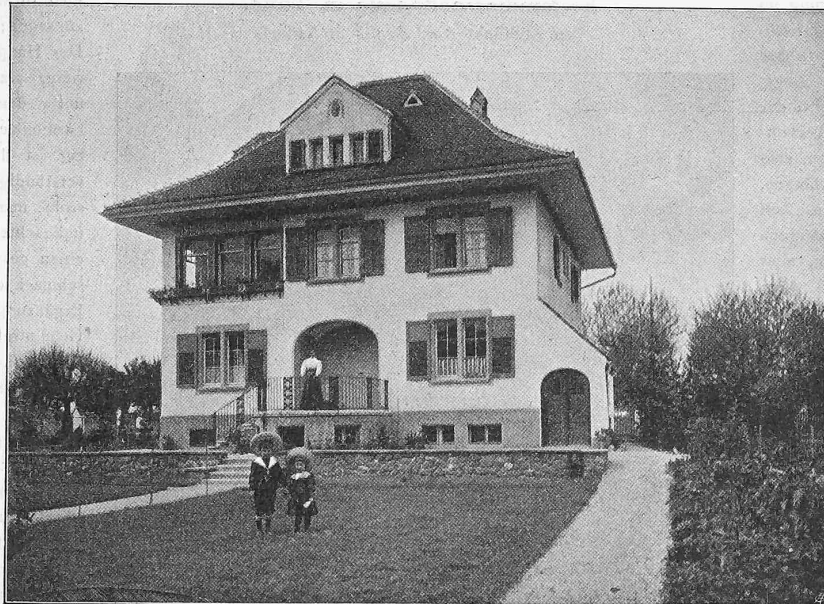
Abb. 7. Gartenansicht des Einfamilienwohnhauses in Thun.
