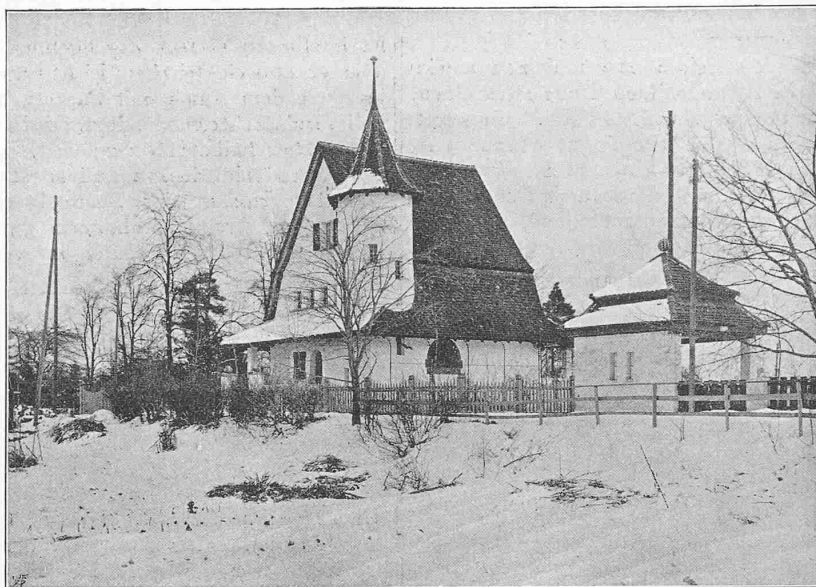
Abb. 4. Ansicht von Südwesten.
