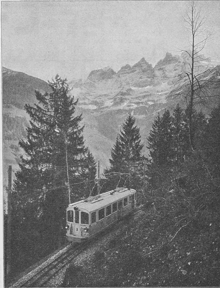
Abb. 17. Motorwägen in Talfahrt auf der obersten Steilrampe.
