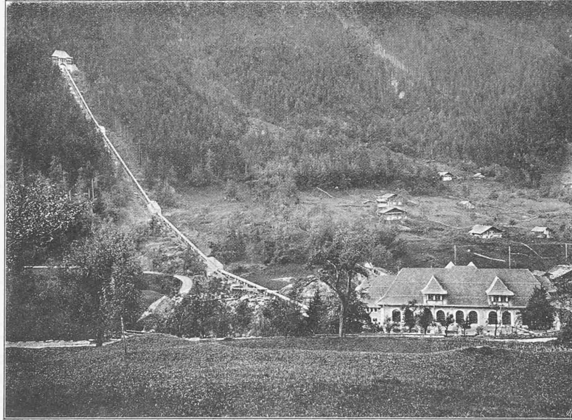
Abb. 15. Wasserschloss, Druckleitung und Maschinenhaus.
