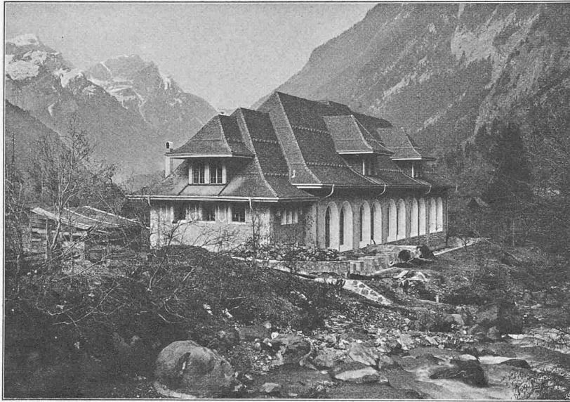
Abb. 21. Das Maschinenhaus vom rechten Ufer der Lütschine aus. Entworfen von Haller & Schindler, Architekten in Zürich.
