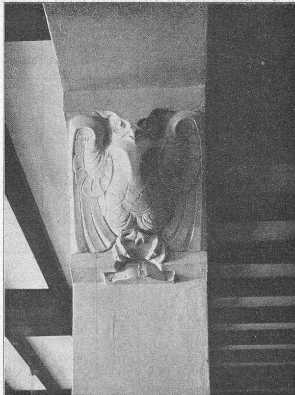
Abb. 11. Pfeilerkapital in der «Schwemme» und Ventilationsöffnungen in der Decke.
