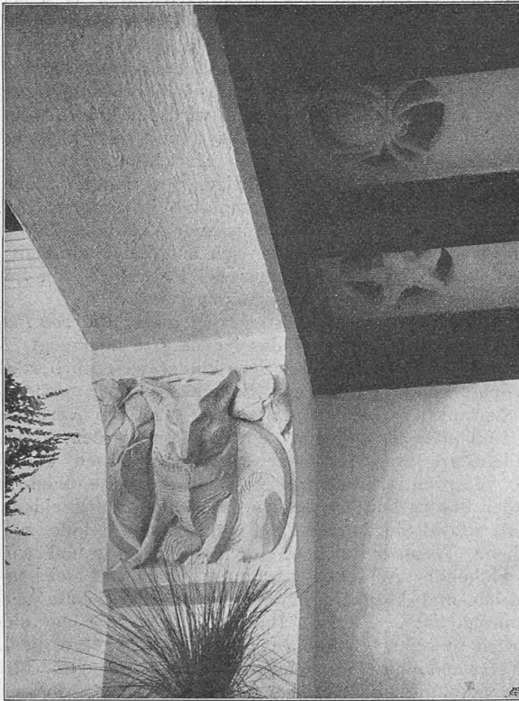
Abb. 10. Pfeilerkapital in der «Schwemme» und Ventilationsöffnungen in der Decke.
