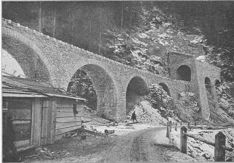
Abb. 7. Portal des Eistöbelitunnels mit Steinschlag-Galerie.
