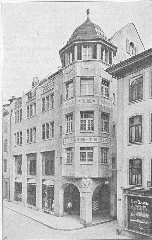
Abb. 4. «Rot-Haus». Gesamtansicht von der Markt-gasse aus.
