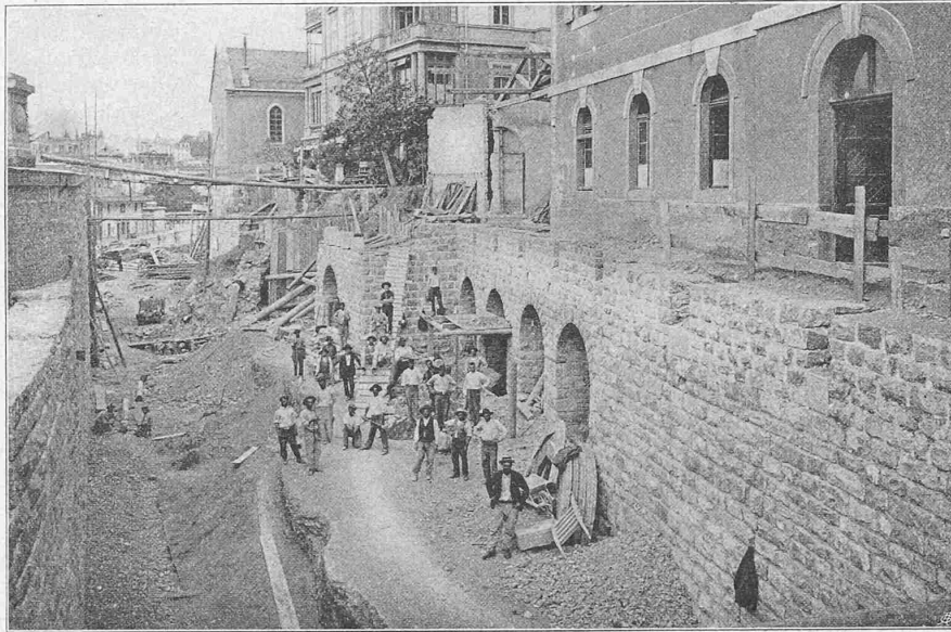
Abb. 14. Durchbruch vollendet; rechts die Gebäude Nr. 5, 6 u. 10; Nr. 7 u. 9 sind abgebrochen.
