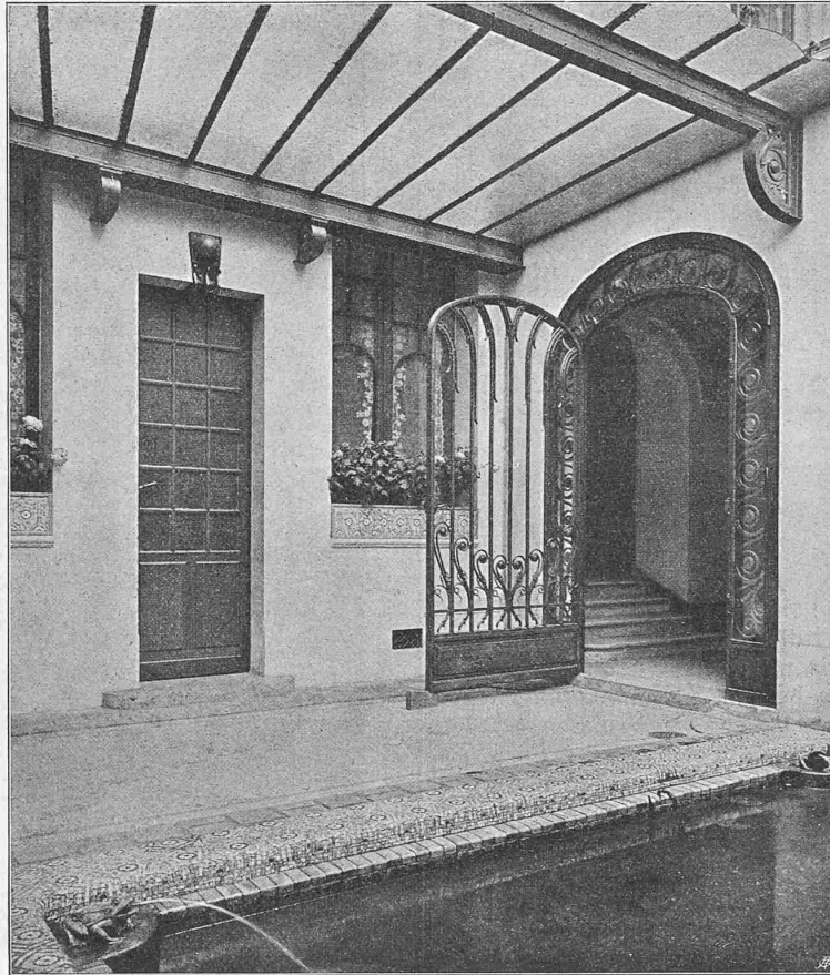
Abb. 13. Licht Hof mit Bassin.
