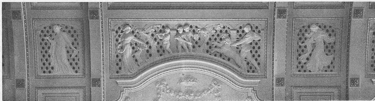
Abb. 9. Lüftungsgitter im grossen Konzertsaal des neuen Berner Casinos. — Architekten: Lindt & Hofmann.
