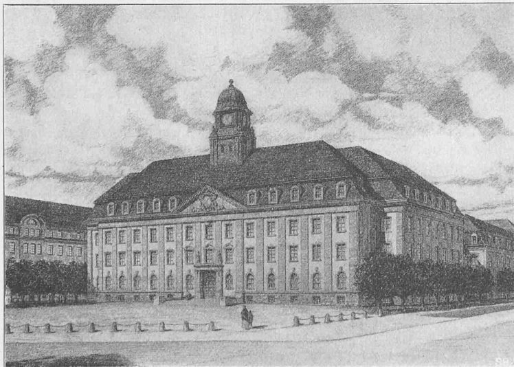
Hauptansicht von der Badenerstrasse aus.
