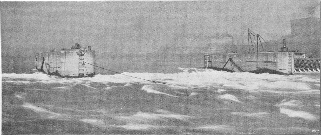
Abb. 5. «Beartrap»-Klappenwehr im Alleghenyfluss (Staufstufe Nr. 1). Stauhöhe 3,6 m, Lichtweite je 28,5 m.
