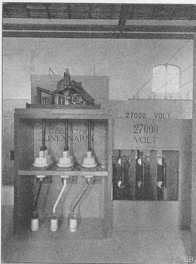
Abb. 14. 27000 V.-Schalter für Linie Narni.
