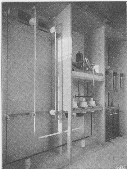
Abb. 21. Hauptschalter d. ankommenden Linie.
