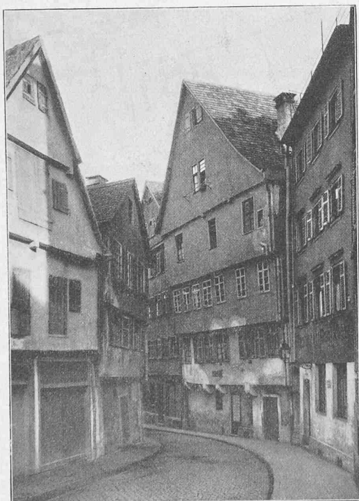
Abb. 2. Blick in die ehemalige Geissstrasse.
