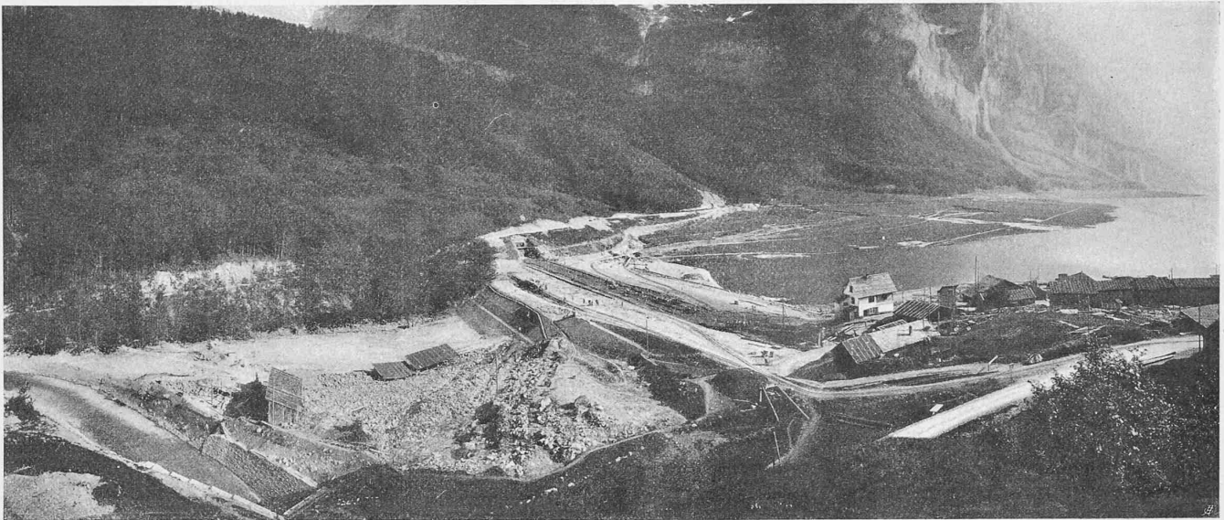
Abb. 15. Gesamtansicht der Baustelle Rodannenbergl, von Norden, im Juni 1909.
