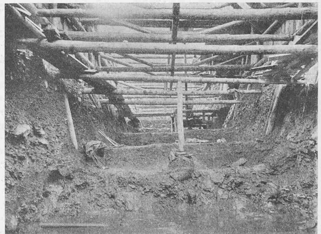
Abb. 14. Ausschachtung der Baugrube für den Lehmkern des Staudammes (Juni 1908).
