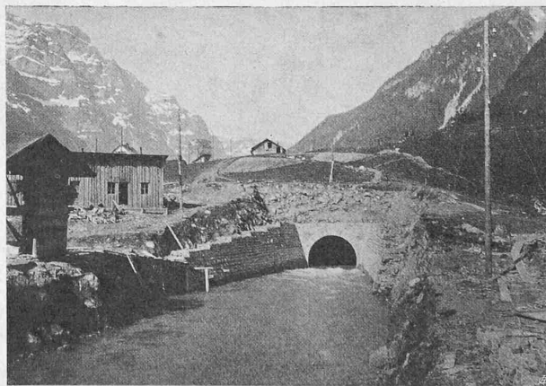
Abb. 32. Untere Mündung des Ablaufstunnels (12. Mai 1908).
