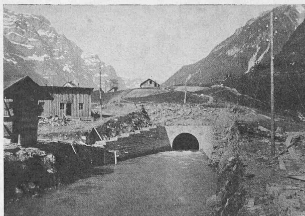
Abb. 32. Untere Mündung des Ablaufstunnels (12. Mai 1908).
