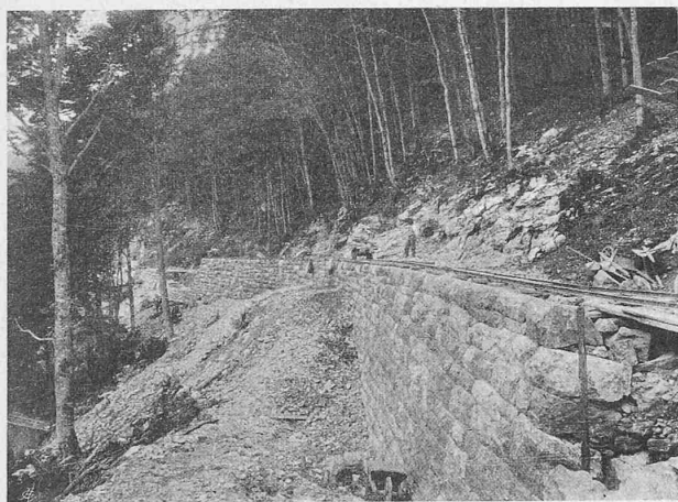
Abb. 35. Trockenmauer an der neuen Strasse (Juli 1907).
