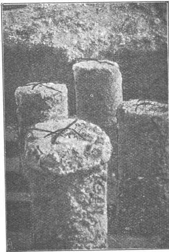
Simplexbetonpfähle
