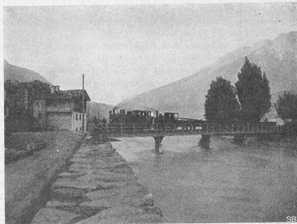
Abb. 23. Dienstbahnbrücke über die Rhone bei Naters.
